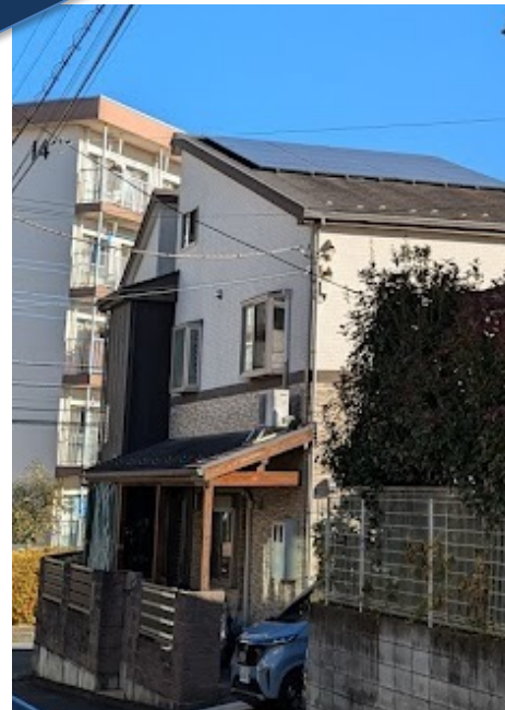
太陽光で発電した電気で充電
